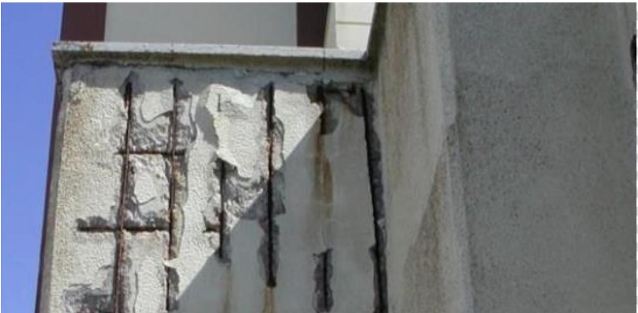
Es la primera causa de deterioro del hormigón, el deterioro no es debido a un ataque químico al hormigón, sino al otro componente que lo conforma, el acero de la armadura. Esta armadura está protegida por el hormigón que la rodea y que le proporciona la alcalinidad necesaria para evitar la corrosión.
