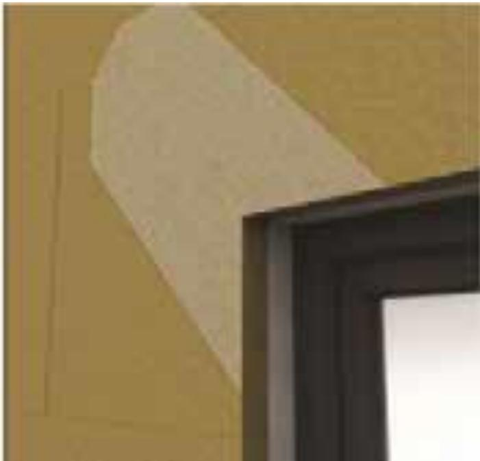
Son mallas de refuerzo resistentes a los álcalis que se aplican en las esquinas de marcos de puertas y ventanas reforzando y armando el revoco para evitar su fisuración.
