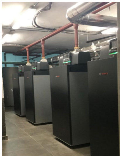
Imagen: Modernización de sala con calderas Condens 7000 F. Instalaciones Sanchez Braojos
