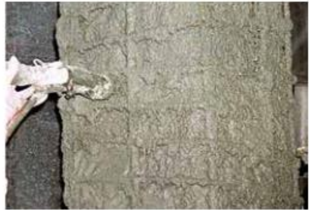
Aumento de recubrimiento de la armadura por proyección
