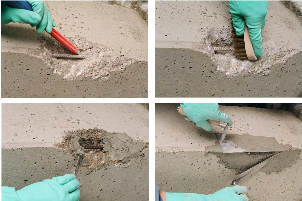
Ilustración de reparación de arista
