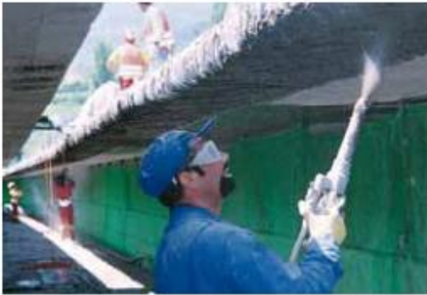
Proyección de hormigón o mortero
