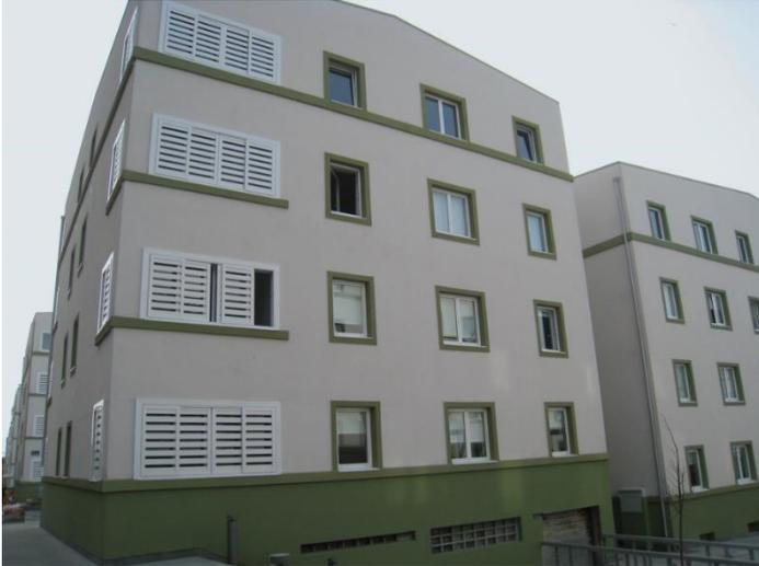
El SATE es un sistema de aislamiento térmico por el exterior que consiste en un panel aislante, adherido a un muro, habitualmente con adhesivo y fijación mecánica.
