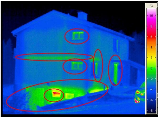
Hay zonas de la envolvente térmica del edificio en el que se pueden evidenciar variaciones de uniformidad de la construcción y donde las propiedades térmicas se pueden ver mermadas considerablemente respecto al resto de la fachada.
